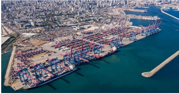
محطة الحاويات في مرفأ بيروت
