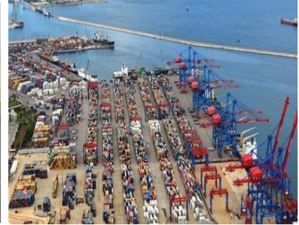
محطة الحاويات في مرفأ بيروت
