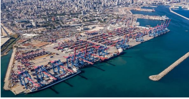
محطة الحاويات في مرفأ بيروت
