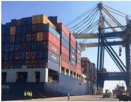
محطة الحاويات في مرفأ طرابلس
