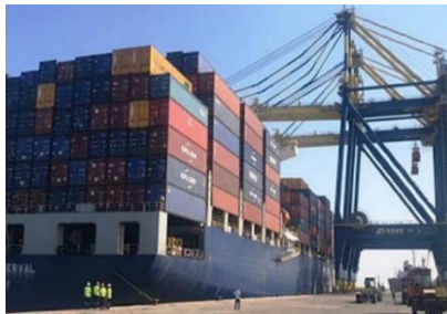
محطة الحاويات في مرفأ طرابلس
