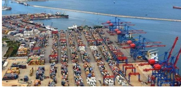
محطة الحاويات في مرفأ بيروت
