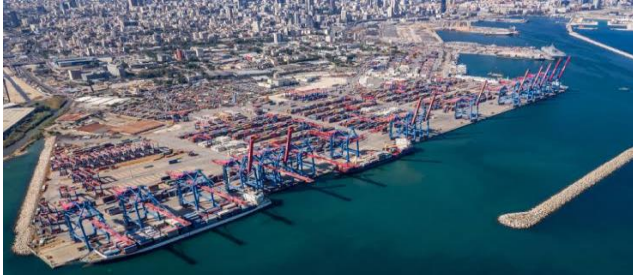
محطة الحاويات في مرفأ بيروت
