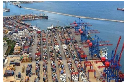
محطة الحاويات في مرفأ بيروت
