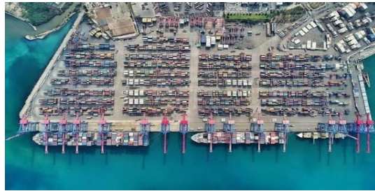
محطة الحاويات في مرفأ بيروت
