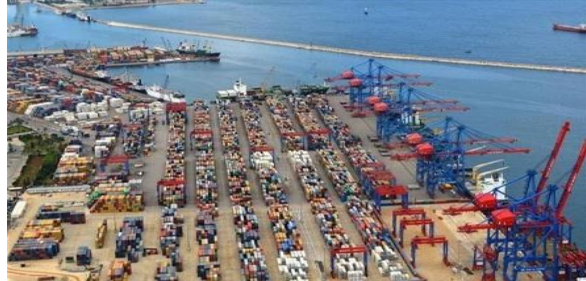
محطة الحاويات في مرفأ بيروت
