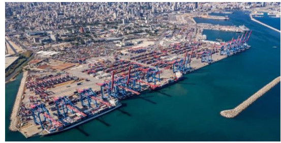
محطة الحاويات في مرفأ بيروت
