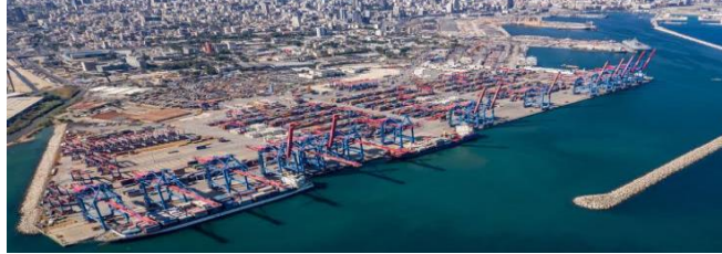
محطة الحاويات في مرفأ بيروت
