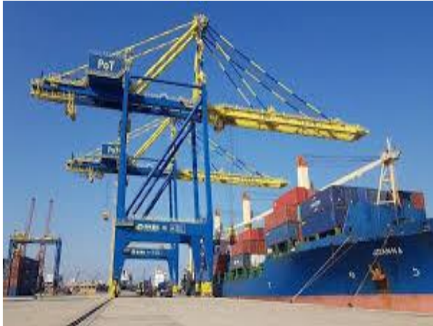
محطة الحاويات في مرفأ طرابلس
