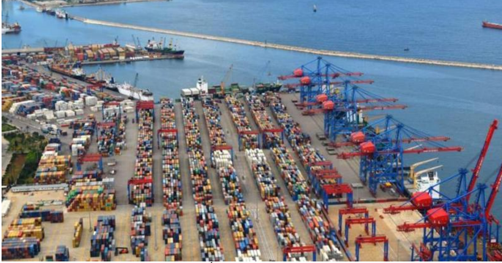
محطة الحاويات في مرفأ بيروت
