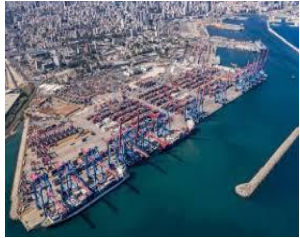
محطة الحاويات في مرفأ بيروت
