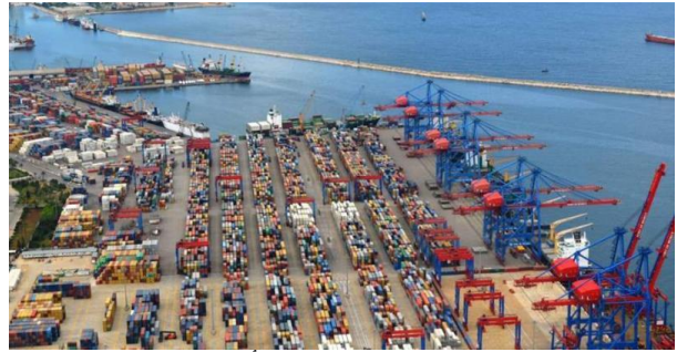
محطة الحاويات في مرفأ بيروت
