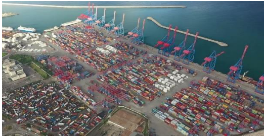
محطة الحاويات في مرفأ بيروت
