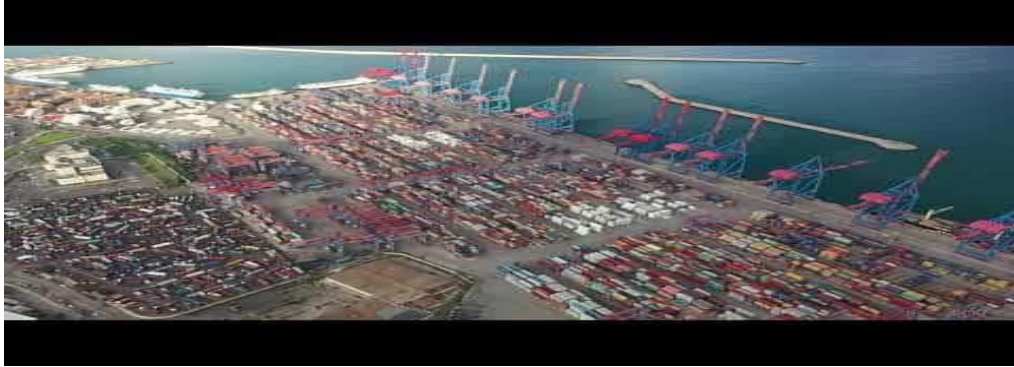
محطة الحاويات في مرفأ بيروت
