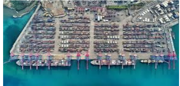
محطة الحاويات في مرفأ بيروت
