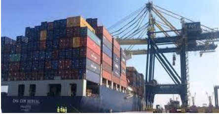
محطة الحاويات في مرفأ طرابلس
