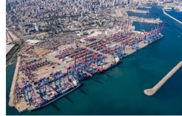
محطة الحاويات في مرفأ بيروت
