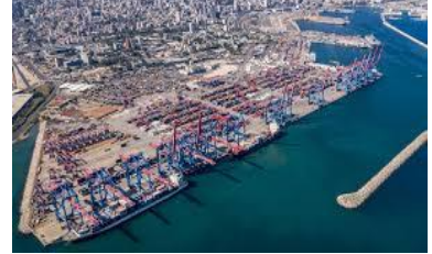
محطة الحاويات في مرفأ بيروت
