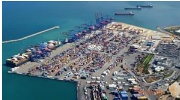
محطة الحاويات في مرفأ بيروت
