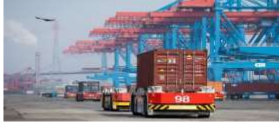
محطة الحاويات في مرفأ بيروت
