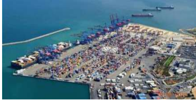
محطة الحاويات في مرفأ بيروت
