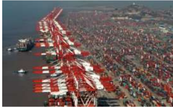
مرفأ Shanghai الصيني
