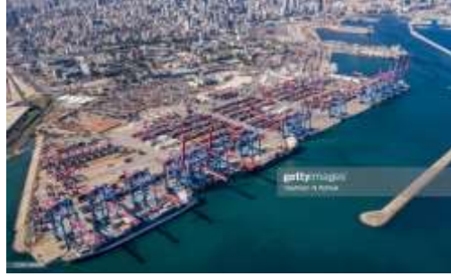
محطة الحاويات في مرفأ بيروت
