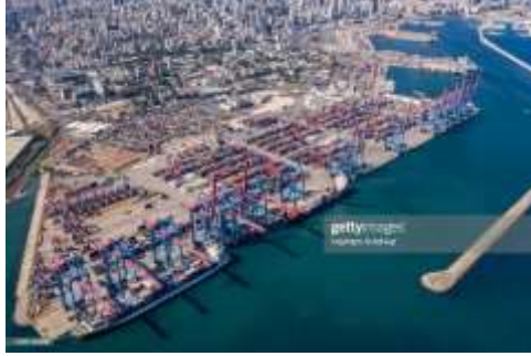
محطة الحاويات في مرفأ بيروت
