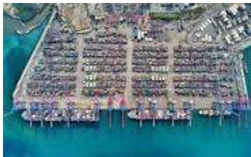
محطة الحاويات في مرفأ بيروت
