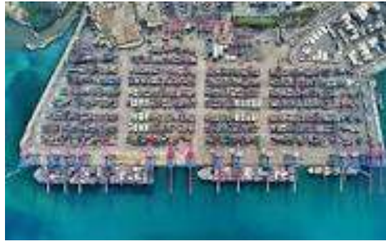
محطة الحاويات في مرفأ بيروت
