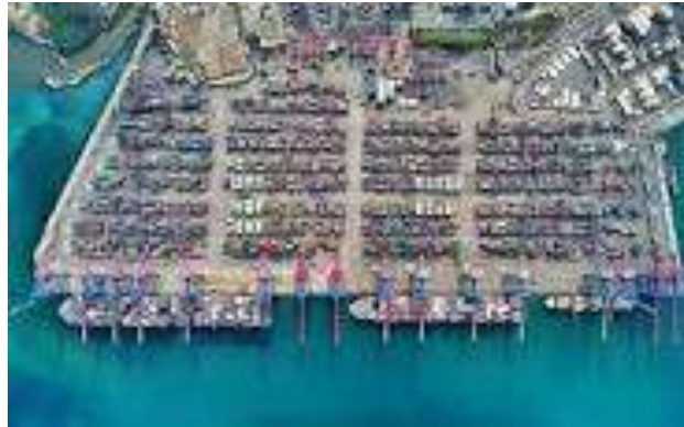
محطة الحاويات في مرفأ بيروت
