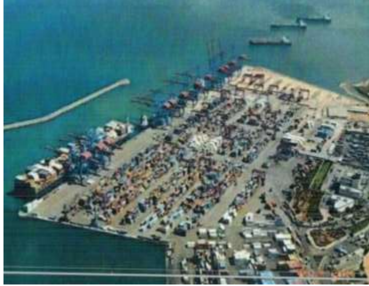
محطة الحاويات في مرفأ بيروت
