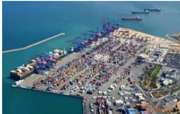
محطة الحاويات في مرفأ بيروت
